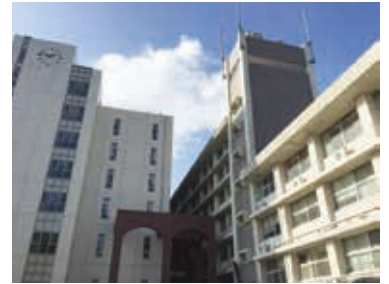
新館右横の取り壊される200号館、300号館
