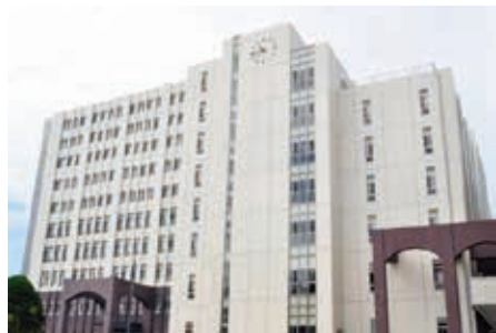
完成した御井本館
