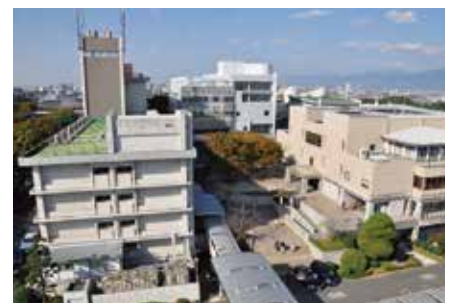
取り壊し予定の200号館
